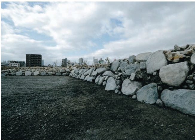
② 大手道の土橋附近
