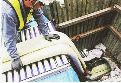
強化プラスチックを老朽化した下水管に注入していく作業員。中央区磯上通7
