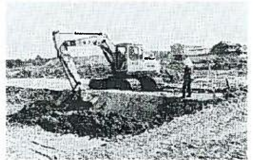
大規模な圃場整備工事
