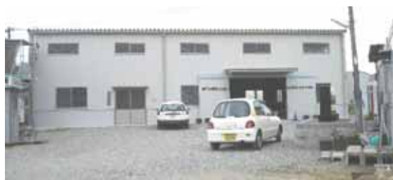
菅野土地改良区施設
