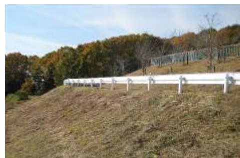
草を刈った法面
