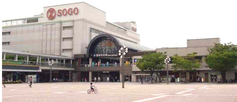
地下鉄西神中央駅
