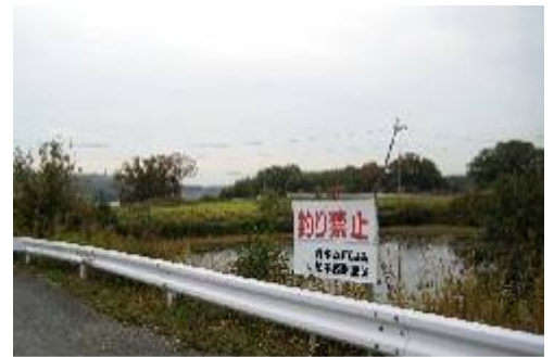
釣り禁止にしているため池
