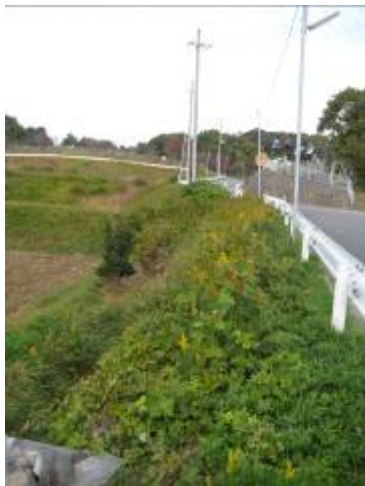
西側連絡道の法面の草刈(前)
