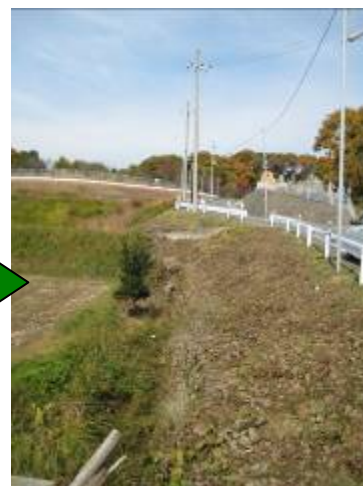
西側連絡道の法面の草刈(後)
