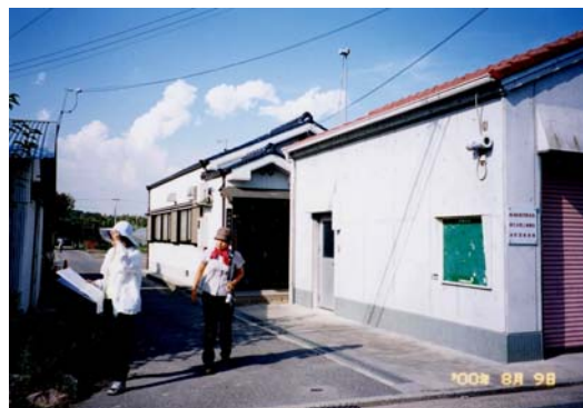
写真3-5 手前は消防機具庫、奥は集会所
