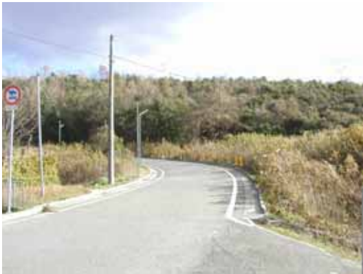
歩道のない道路
