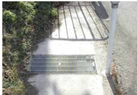
早速対応された排水設備
