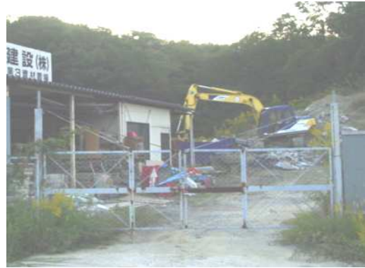
写真 3-2 地区にある資材置き場の様子
