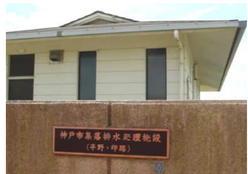
写真 3-10 集落排水施設
