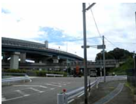
集落を通る高速道路(下地区)
