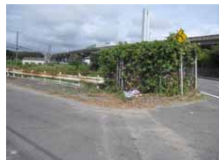
フェンスに雑草がからまり見通しが悪い
