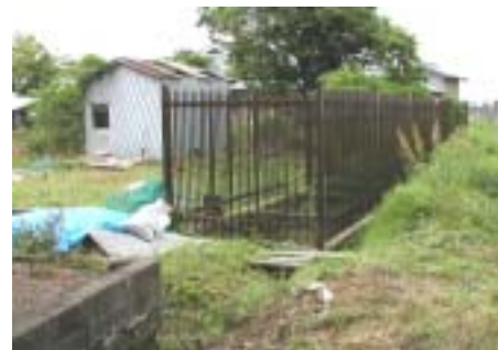
防火水槽の清掃を行う
