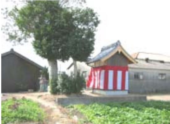
改築工事が行われた(14年9月)
