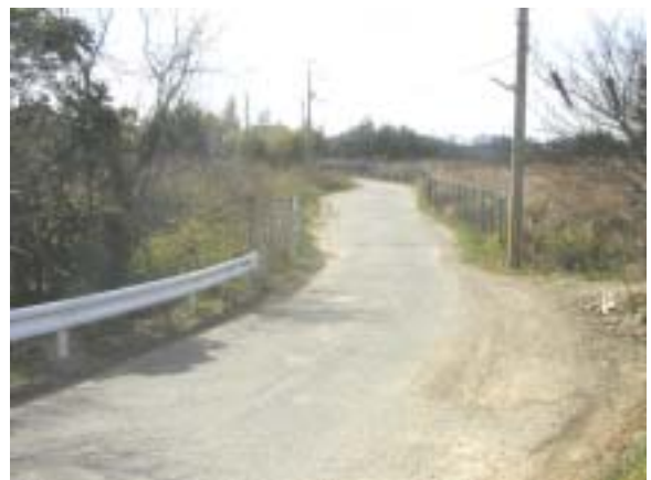
岩ヶ谷付近の道路：整備したいが登記ができていない
