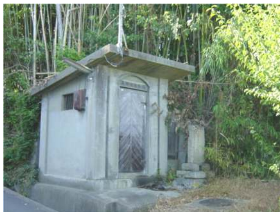
写真 2-7 簡易水道の取水口
