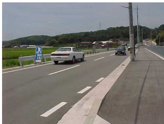
写真 3-3 市道西戸田・中村線(拡幅工事中)
