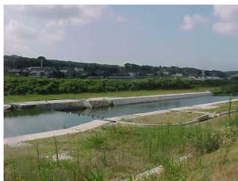
写真 2-4 林崎掘割水路の起点(上湧)
