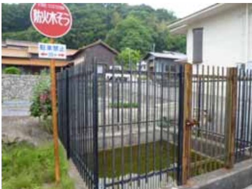
写真 . 防火水槽
