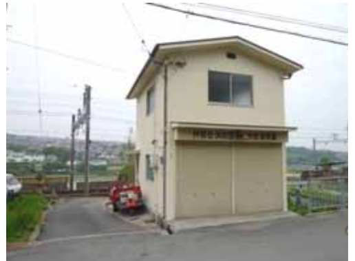
写真 . 消防器具庫
