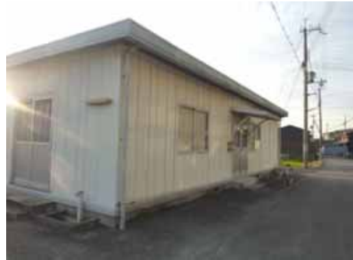
写真 . 木幡公会堂 別棟
