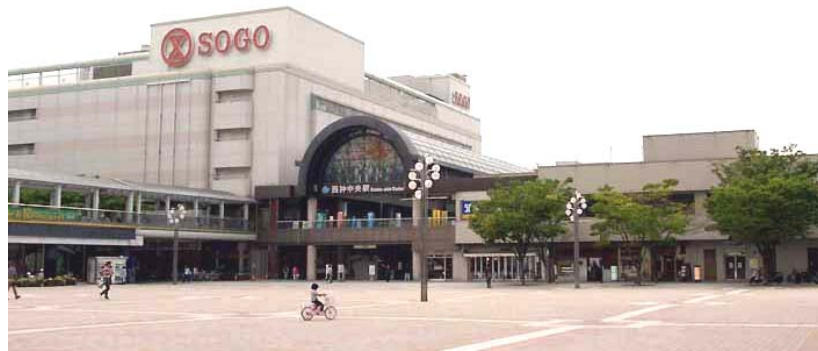
地下鉄西神中央駅
