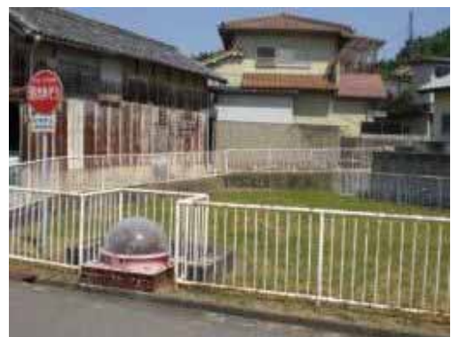
写真．防火水槽
