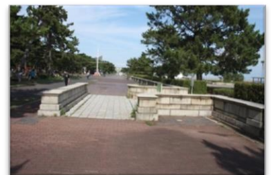
水門遺構 (住友別邸跡)
