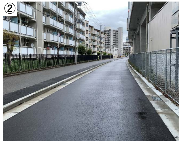
青木幹線西側車道部暫定供用中
