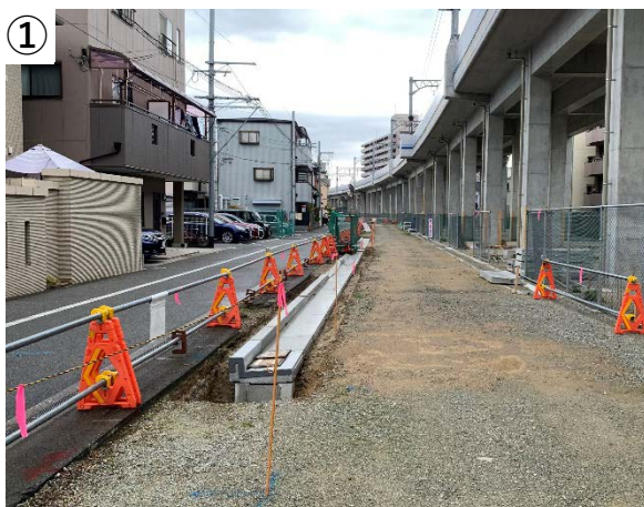
魚崎地区側道工事中
