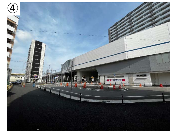
深江駅北側広場暫定供用中
