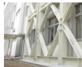
小学校の耐震改修例
