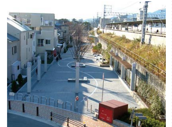
広場東側より
