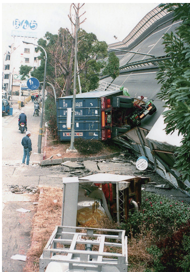
自動車もろとも倒壊した阪神高速道路神戸線
