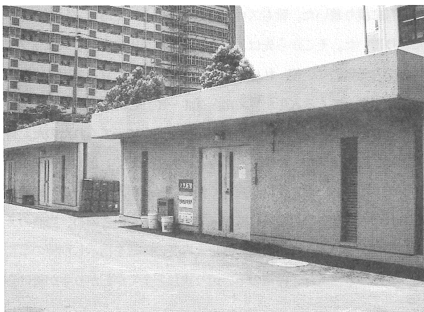
被害が少なかった屋内貯蔵所（右）と一般倉庫（左）
