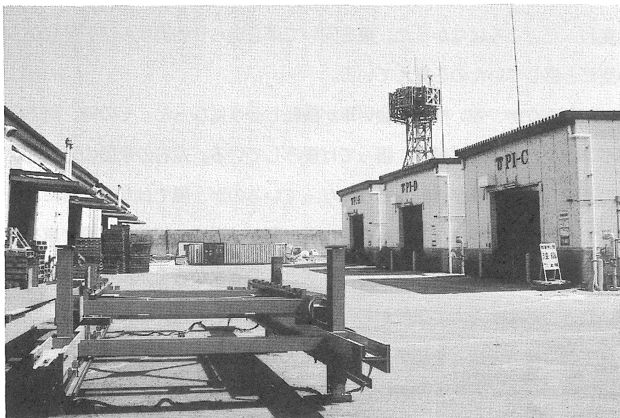
震災当時、液状化現象により泥水で埋めつくされていた構内
