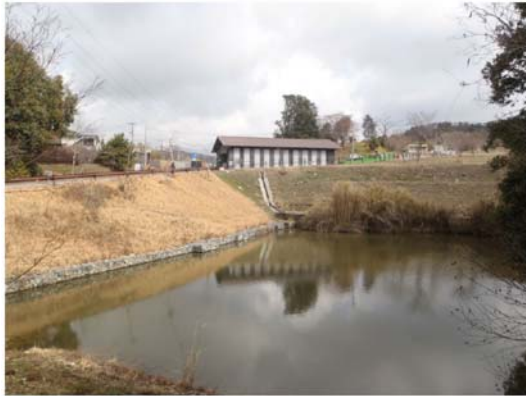
撮影日：平成 31 年 2 月 20 日 写真 4-1 工事箇所下流の調整池の状況
