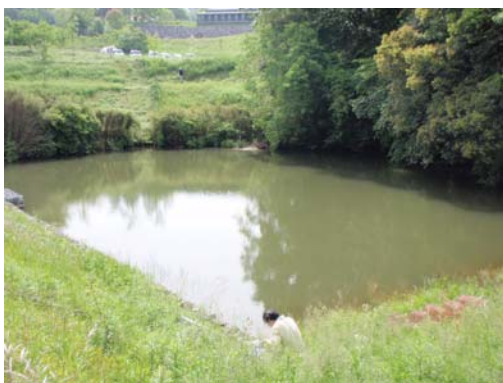
撮影日：平成 30 年 5 月 16 日 写真 4-25 棚-002 (相坂池)
