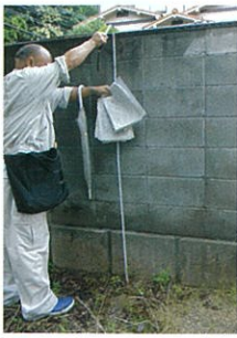
ブロック塀の緊急安全点検
