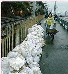
▲塩屋2丁目の土砂を住民の方と撤去
