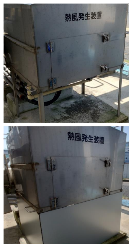
図4 乾燥機の熱風発生装置
