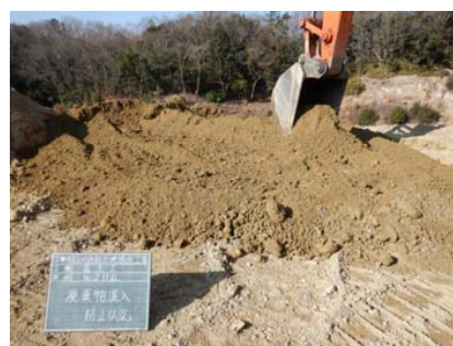
均し作業時の目視
