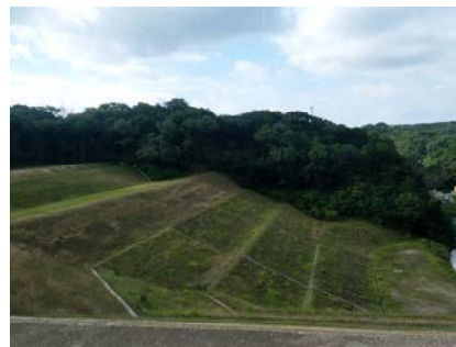
北側からの緑化法面
