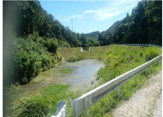
調整池上流から
