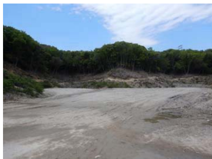
盛土作業の目視
