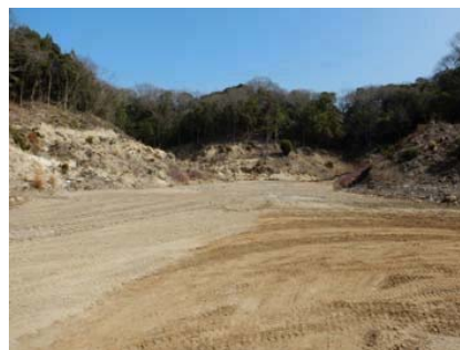
盛土作業の目視
