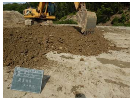
均し作業時の目視
