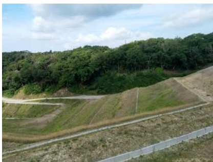
東側からの緑化法面
