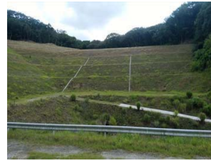
西側からの緑化法面
