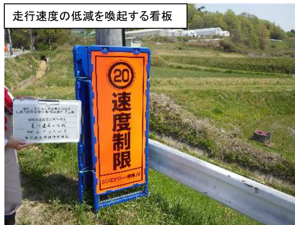
写真 3.3-2 環境保全措置の実施状況（振動）
