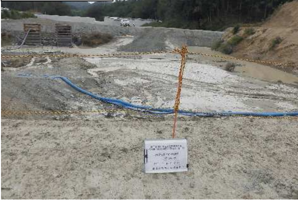
沈砂池の設置状況
