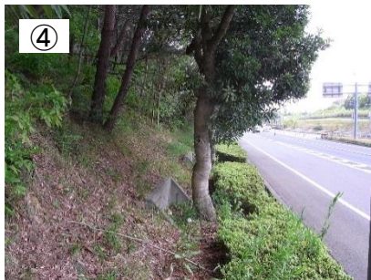
④ 現道法面 (拡幅部)
