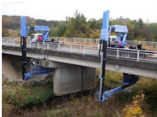
橋梁点検（長坂橋）
