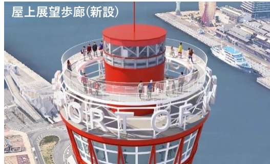
低層部4階屋上テラス(新設)
