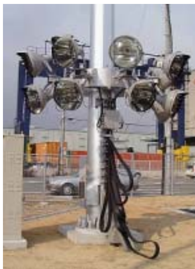
昇降式照明塔 (器具を降ろした状態)
