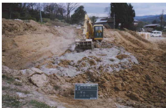
セメント混合処理の状況
