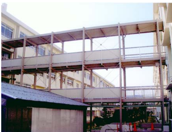
屋外渡り廊下
