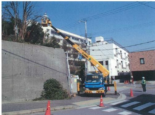
仮歩道を適切に設置するなど歩行者への配慮がなされておらず、歩道に工事用車両を乗り入れて作業している
