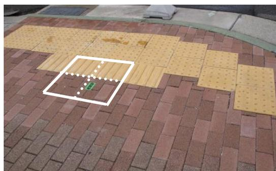
線状ブロックを縦2列に2枚ずつ設置すべきところ、横1列に4枚設置していた。(長田区)
