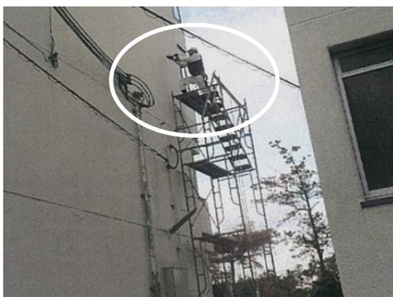
最上層の作業床に手すりが残置されておらず、下層の階段も撤去されている
