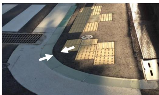
車道横断部の歩道巻き込み部は縁石ブロック背面より30cm控えて設置すべきところ15cm程度としている。(須磨区)
