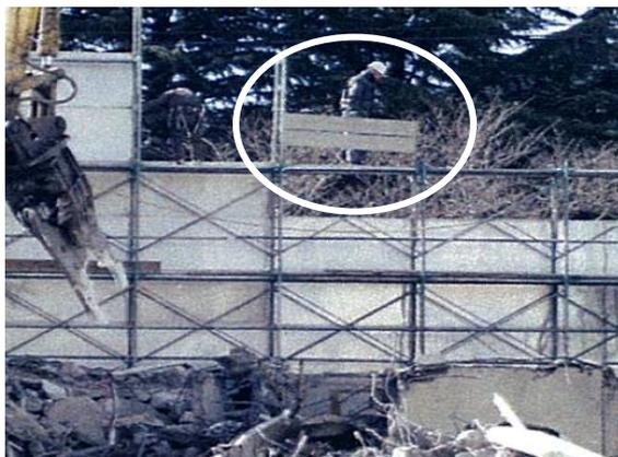
最上層の作業床に手すりが残置されていない
