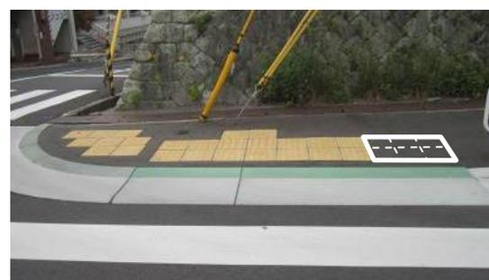
点状ブロックの設置幅は通行可能幅とすべきところであるが、一部設置されていない。(須磨区)
