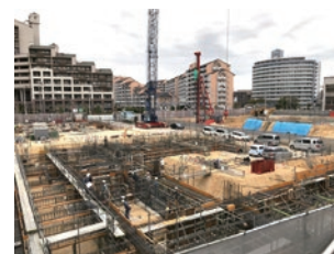
新・西図書館建設現場
