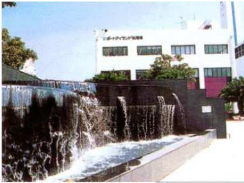
ポートアイランド処理場
