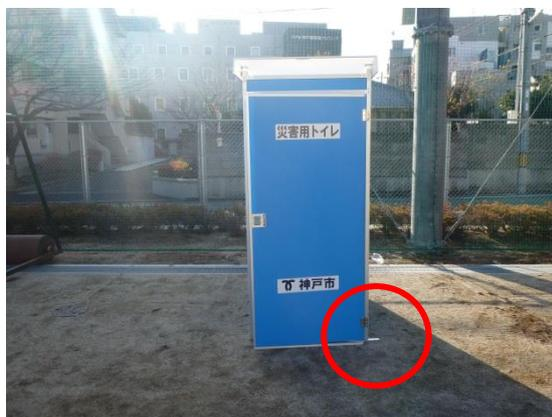
⑬アイボルト4本にロープを結び、一方をグラウンドに打ち付けたペグに結び付け、上屋パネルを地面に固定します。
