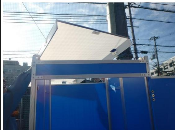
※屋根と上屋パネルのアイボルト取付用の穴の位置が合うように位置を調整します。
