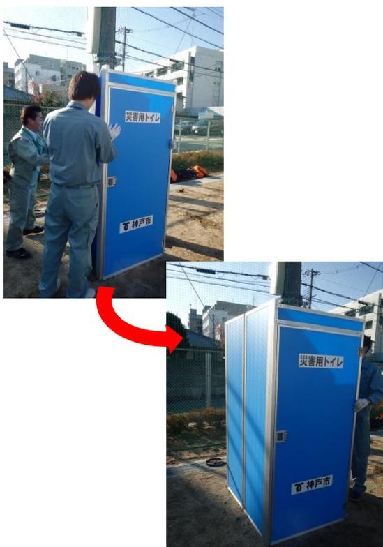
⑧床板パネルを排水ジョイントの穴位置にあわせて置き、上屋パネルを床板パネルに合うように設置します。
