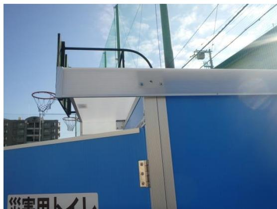
⑪アイボルトで屋根を上屋パネルに固定します。(4箇所)
