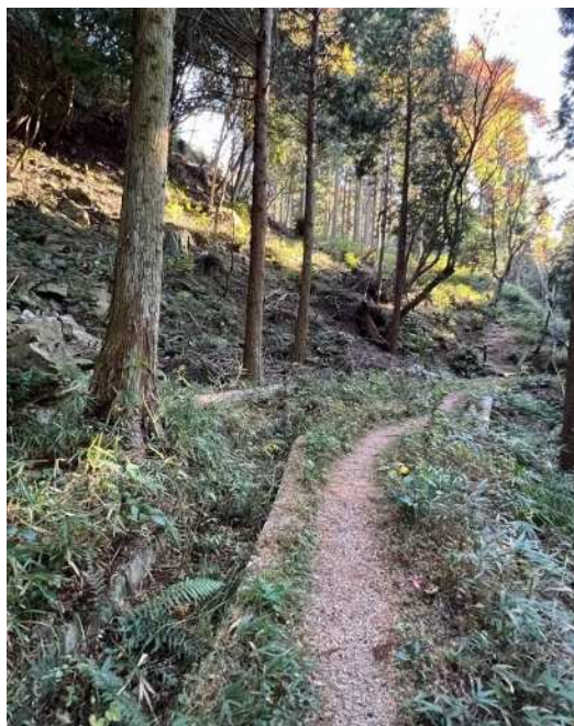
現況写真：導水路
