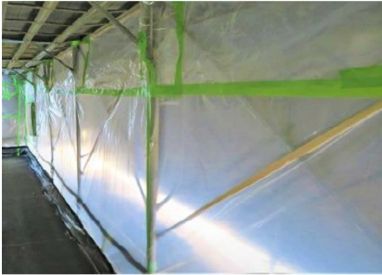
周囲への飛沫飛散防止養生イメージ(内部)
