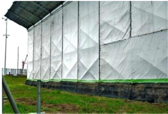
周囲への飛沫飛散防止養生イメージ(外部)
