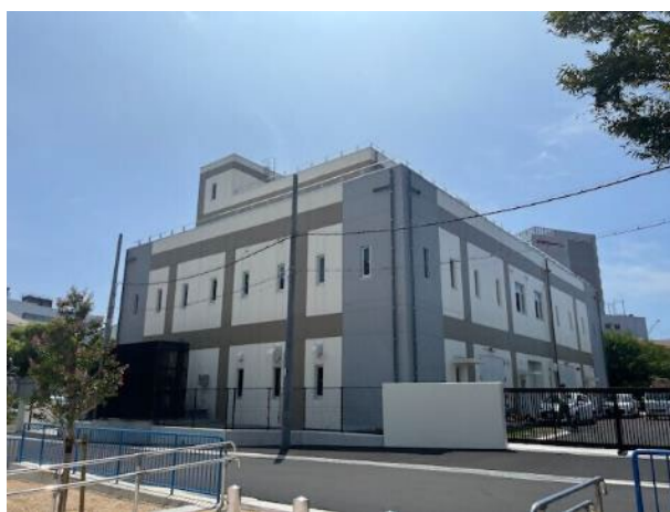
図5 東川崎ポンプ場
