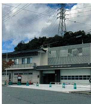
西神南消防出張所全景
