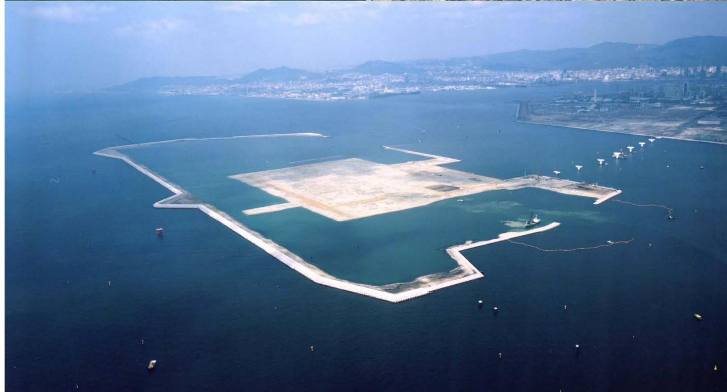
2003.12 連絡橋の道路桁架設
