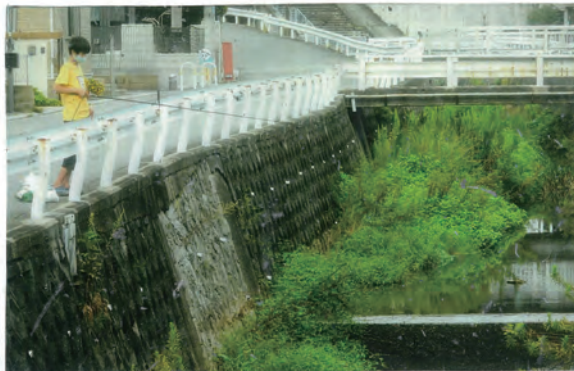
明石川支流の田中川は3面コンクリート張りていかに降られないので釣りで馬区除をしています。
