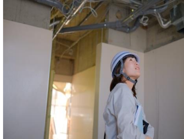
工事現場の監理業務
