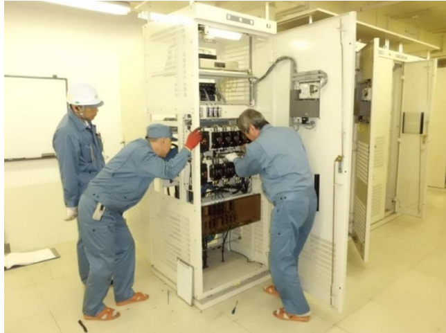
電気設備の点検
