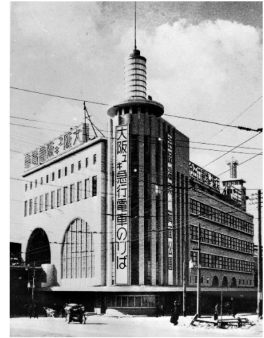
旧神戸阪急ビル東館の外観
