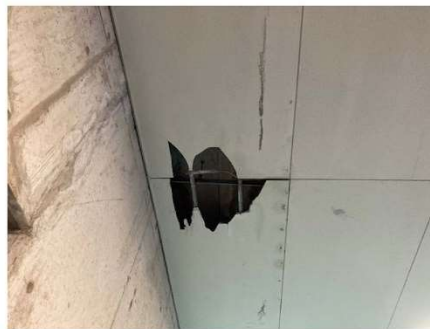
令和5年4月 上部観客席の雨水が天井内に漏水。雨水によりボードが劣化し、落下。
