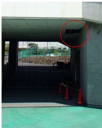
令和5年4月 上部観客席の雨水が天井内に漏水。雨水によりボードが劣化し、落下。
