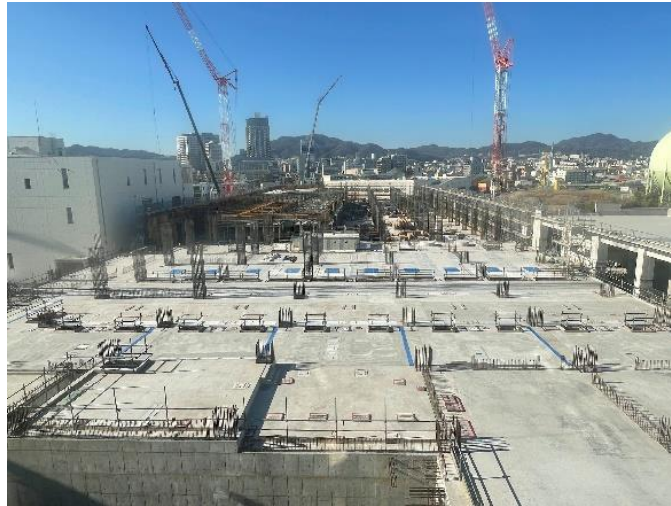
西部処理場北系整備（長田区）
