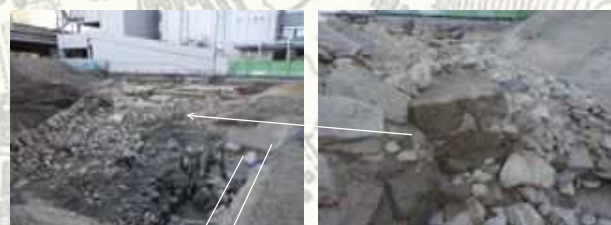
生田川からの砂の堆積 砂浜の堆積 南側の防波堤 粘土ブロック積みの部分
