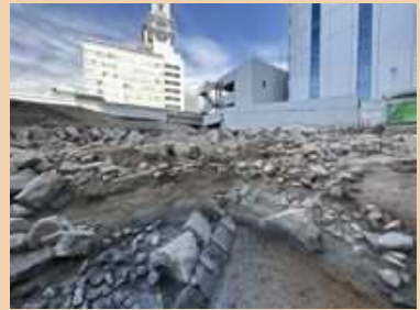
調査区南西部 第Ⅰ期石積み上層 信号所の構築状況
