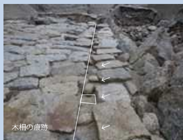
信号所の壁=防波堤築石 敷石 第Ⅲ期防波堤 栗石(裏込め) 暗渠状の溝 第Ⅰ期防波堤 栗石(裏込め) 柵列の木柱
