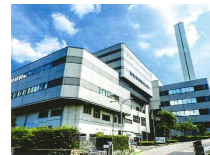
西クリーンセンター全景
