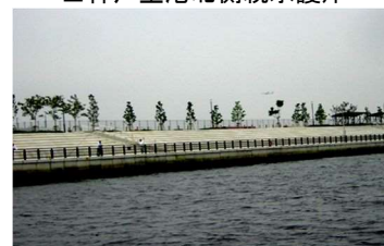
■神戸空港北側親水護岸
