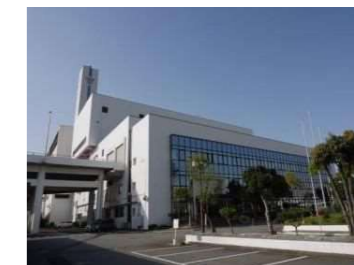
旧港島クリーンセンター全景
